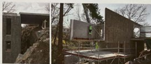
MEGA-LEGO. T-huset skruvades ihop av specialbeställda betongelement. I bakkant ett slags vindbrygga som fungerar som uteplats och är förankrad i berget.
