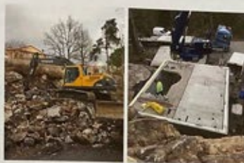
MEGA-LEGO. T-huset skruvades ihop av specialbeställda betongelement. I bakkant ett slags vindbrygga som fungerar som uteplats och är förankrad i berget.
